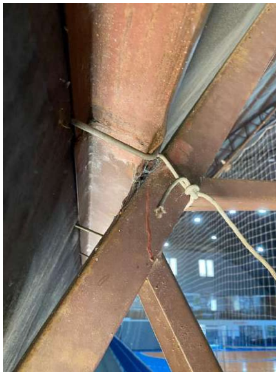
Imagem 20 - Junção terça metálica e treliça principal
