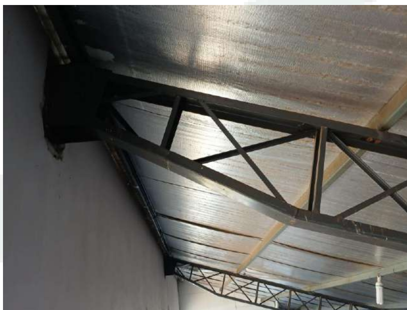
Imagem 16- Apoio treliça inclinada em pilar
