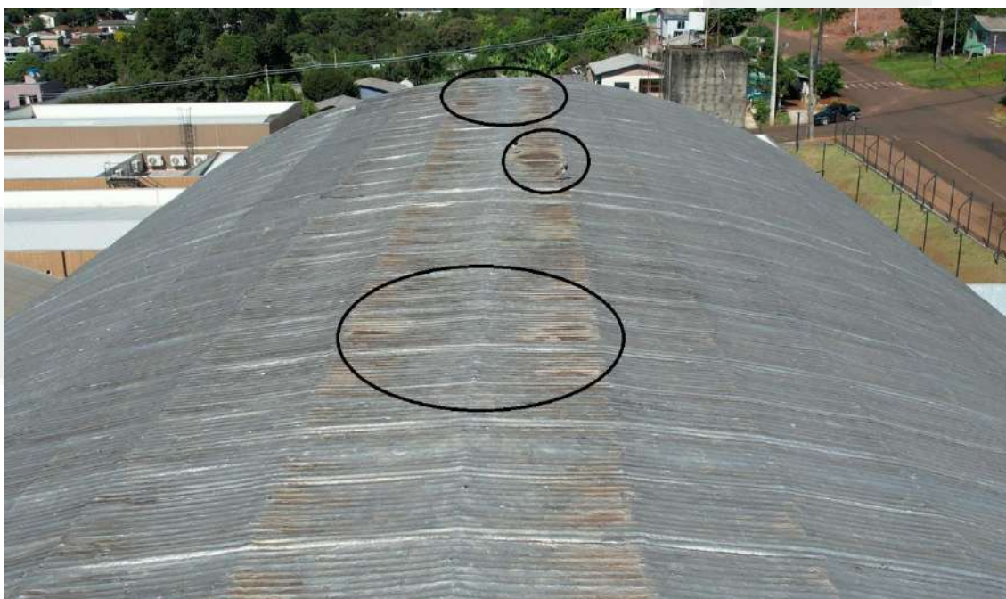
Imagem 25- Danos em cobertura metálica
