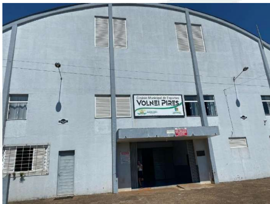
Imagem 4- Vista do acesso principal da edificação
