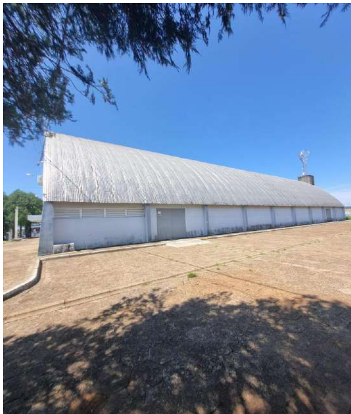
Imagem 7- Vista da lateral direita do edifício
