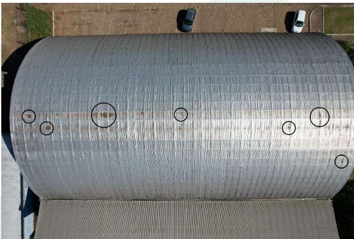
Imagem 23- Vista superior da cobertura
