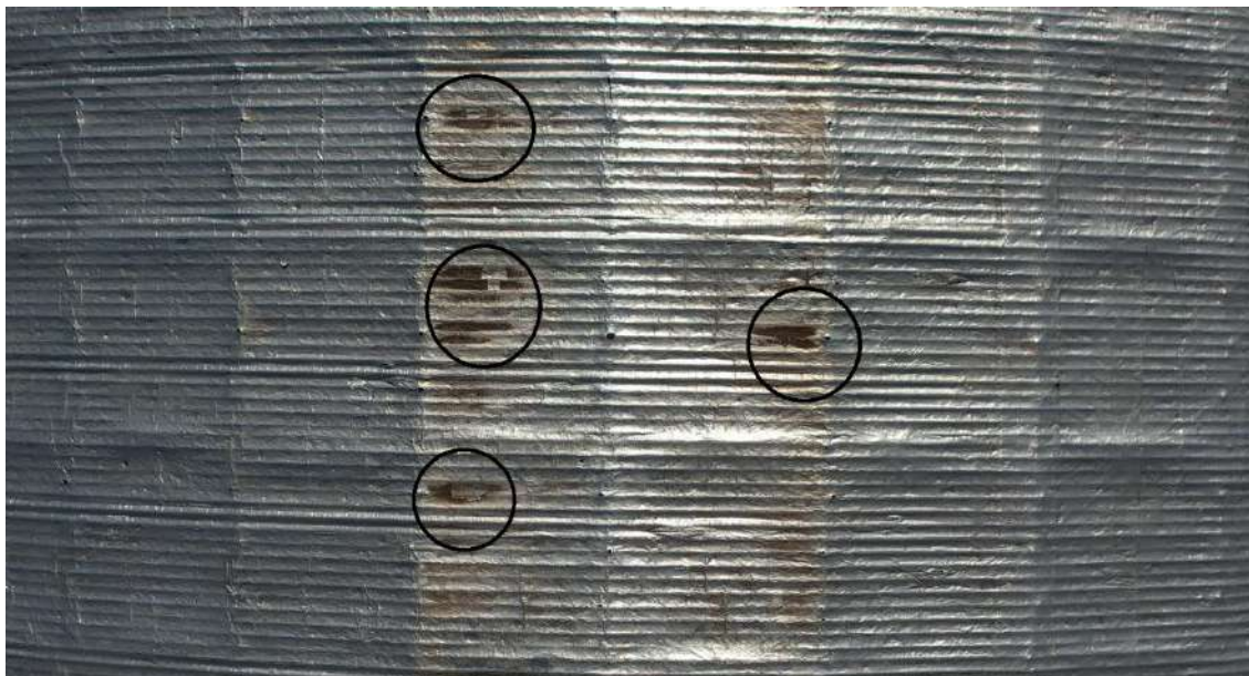
Imagem 25- Danos em cobertura metálica
