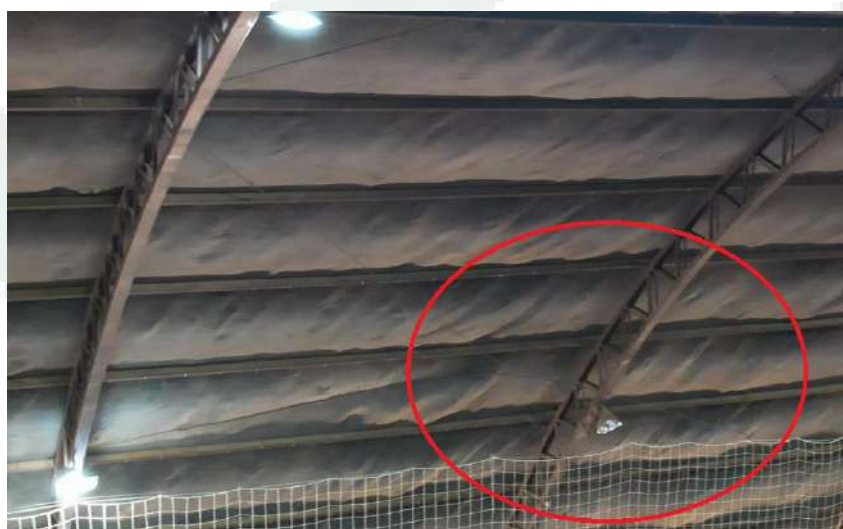
Imagem 28 - Contraventamento rompido
