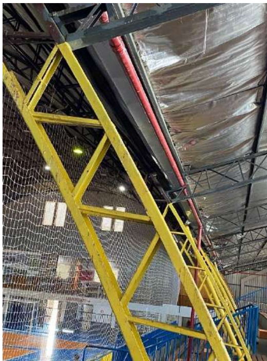
Imagem 11- Junção entre treliça principal e treliça inclinada
