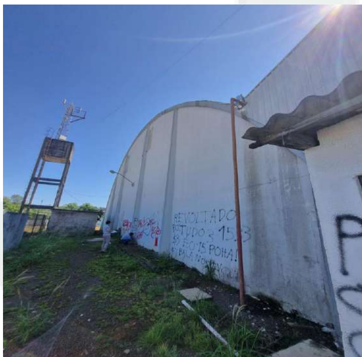
Imagem 6- Vista dos fundos do edifício
